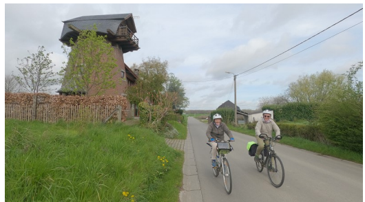
A Grand-Leez (Gembloux), plusieurs moulins à vent ont été réhabilités, comme celui-ci, transformé en habitation.
