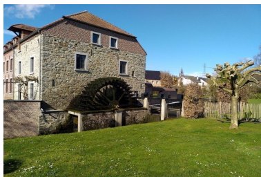
Moulin à eau (Court-Saint-Etienne)
